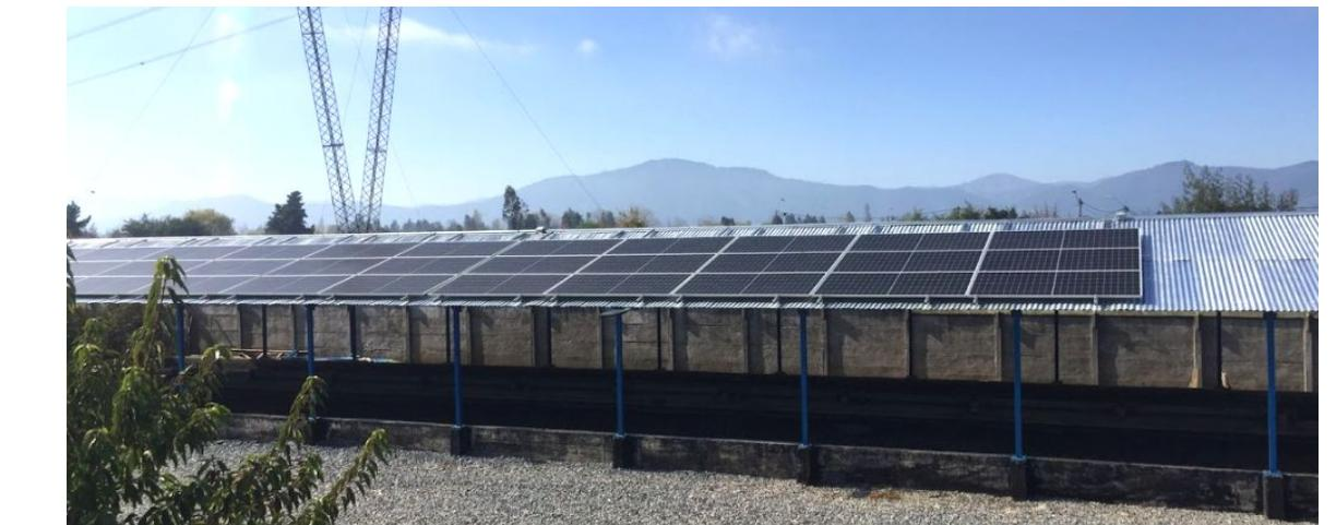
Planta fotovoltaica individual de 16,7 kW en la planta de tratamiento de agua sanitaria de Cumpeo. Permite disminuir el precio del m<sup>3</sup> de agua. *Implementado por Red Genera.*
